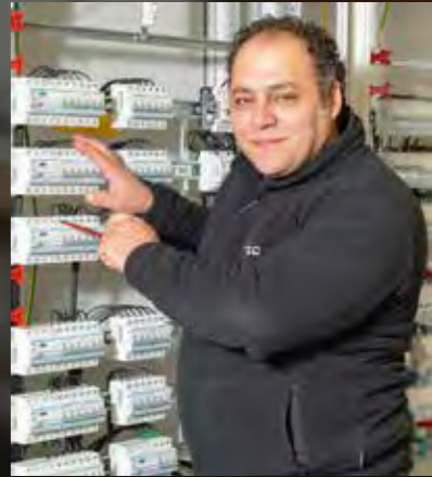
DAS ZUSAMMENBAUEN VON SCHALTSCHRÄNKEN für Kunden aus der Automobil-, Pharma und Erdöl-industrie gehört für Abou Aasali, der in der Firma Igatec Speyer eine Umschulung macht, genauso zum Aufgabengebiet wie das Verlegen von Kabeln auf Baustellen.
